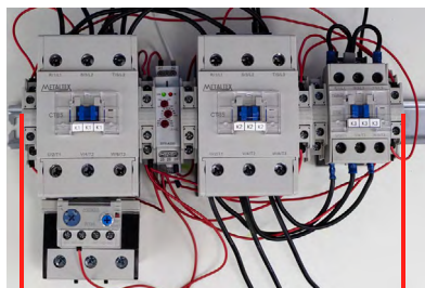
Sistema de contactor estrella-triángulo tradicional
